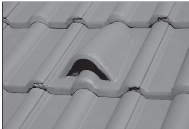
Detailní záběr na tašku větrací ve střeše
